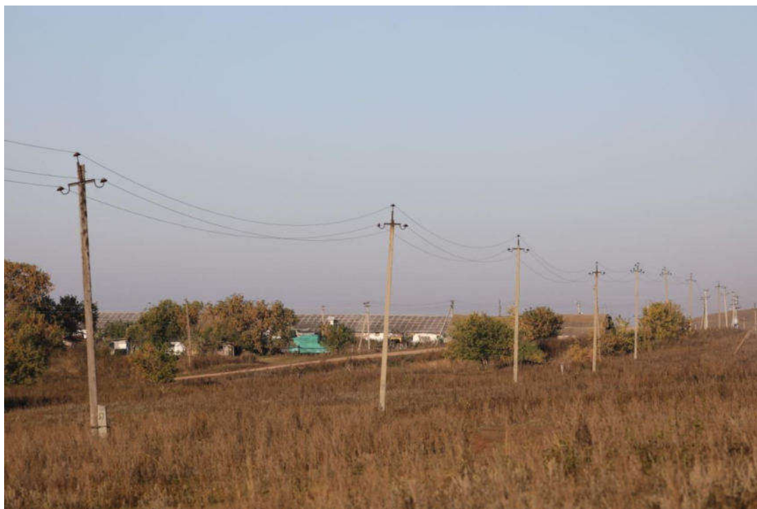
Рисунок 3-35. Птицеопасная ЛЭП без ПЗУ (Пашкинский ЛУ)
