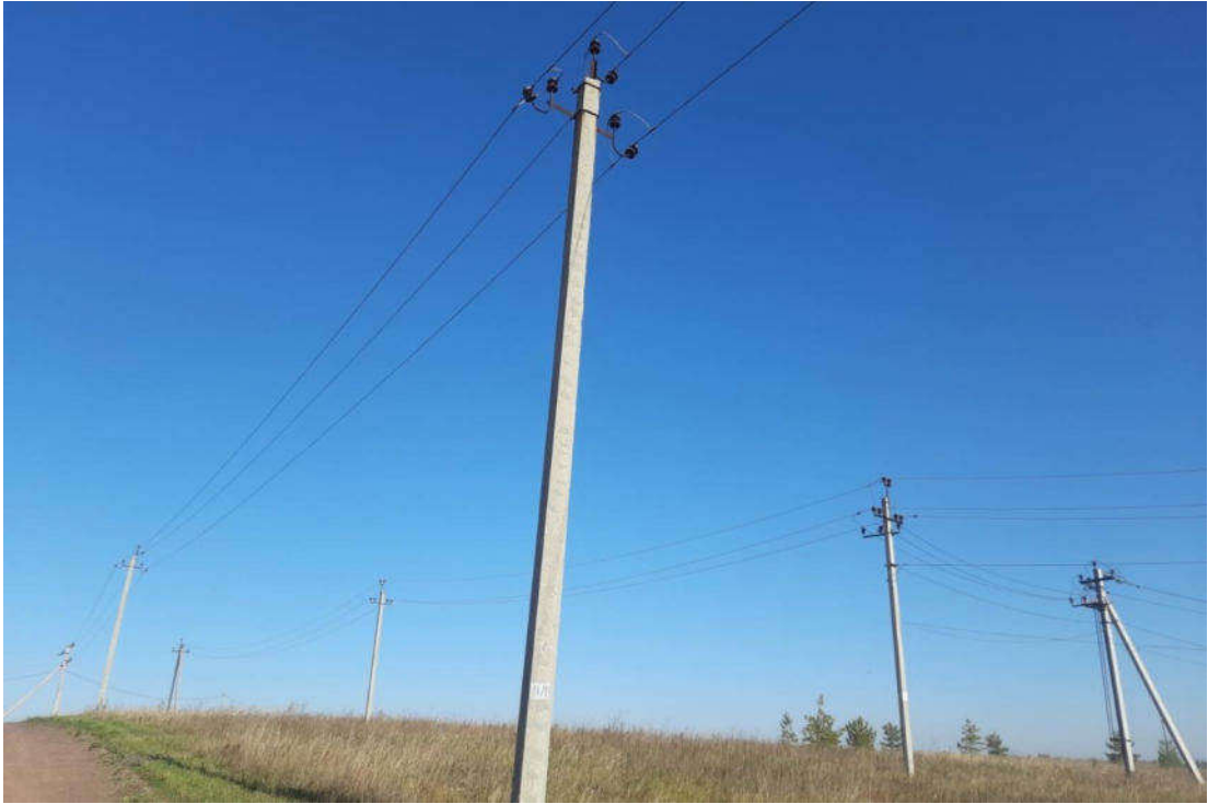
Рисунок 3-41. Птицеопасная ЛЭП без ПЗУ (Кирсановский ЛУ)
