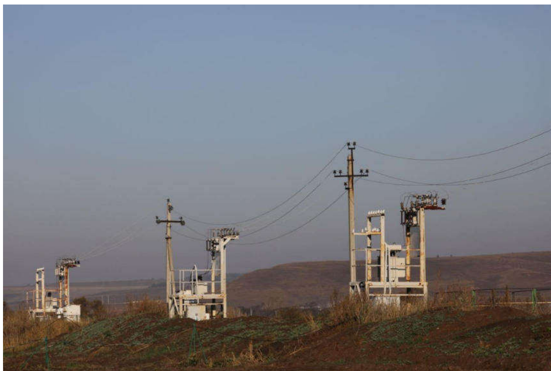
Рисунок 3-36. Птицеопасная ЛЭП без ПЗУ (Пашкинский ЛУ)
